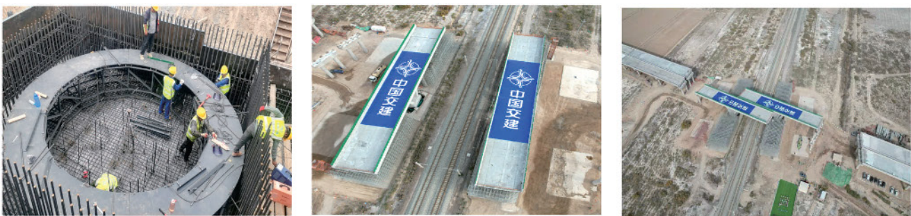
新疆乌尉公路PPP项目12标 转体支座
