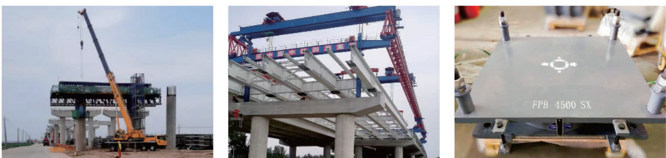
黄河高速YZSG-3标项目 摩擦摆、高阻尼、水平力分散型隔震支座橡胶支座
