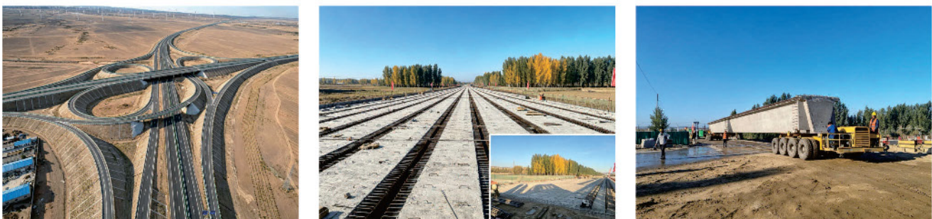
红旗农场-阿图什公路（工程施工）项目 水平力分散型、高阻尼隔震橡胶支座、橡胶支座
