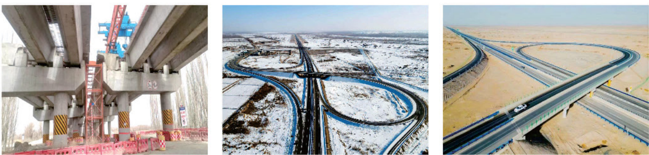
新疆乌尉公路PPP项目12标 球形、摩擦摆减隔震球形、高阻尼减隔震支座
