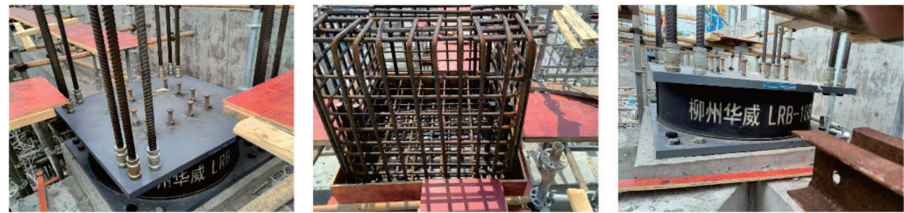
海南省托育综合服务中心项目 房建支座
