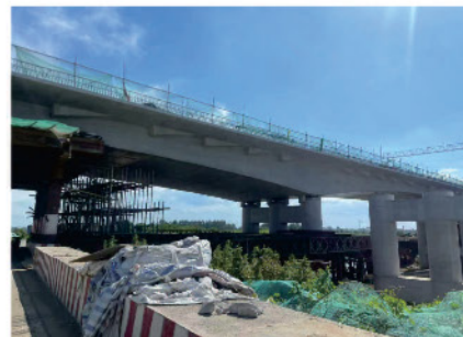
长兴至高淳高速公路3标项目 盆式、板式橡胶支座、摩擦摆减隔震支座
