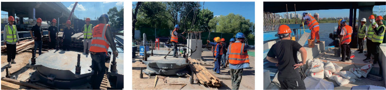
江苏宿迁大道快速化改造工程 摩擦摆支座、铅芯减隔震橡胶支座
